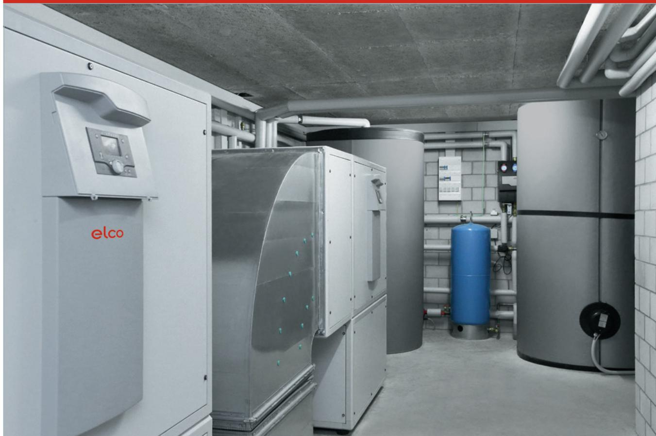
Les deux pompes à chaleur air-eau AEROTOP T26 sont montées en cascade et l'air d'alimentation provient du garage souterrain.
