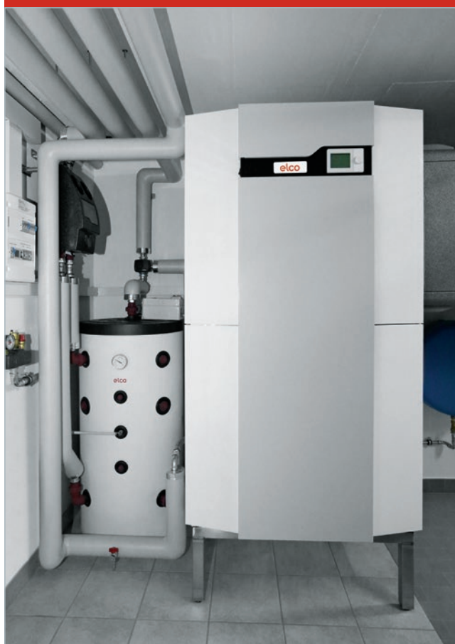
Neue Wärmepumpenheizung
