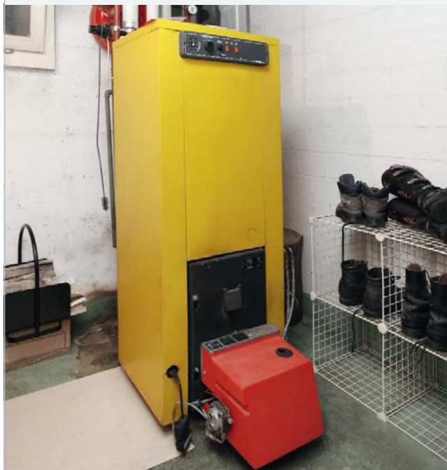
Die alte Ölheizung vor der Demontage.
