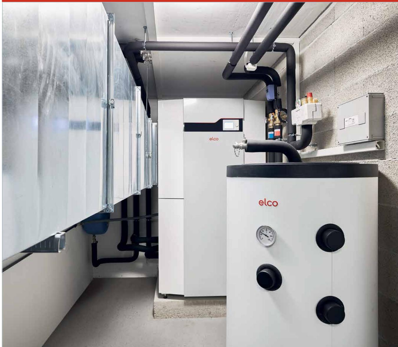
Tenuto conto della forma a budello del locale tecnico, il canale dell'aria (a sinistra) per la termopompa (al centro) risulta insolitamente lungo.
