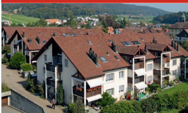
Vue sur le complexe résidentiel Obristweg 8-18 d'Oftringen (AG).
