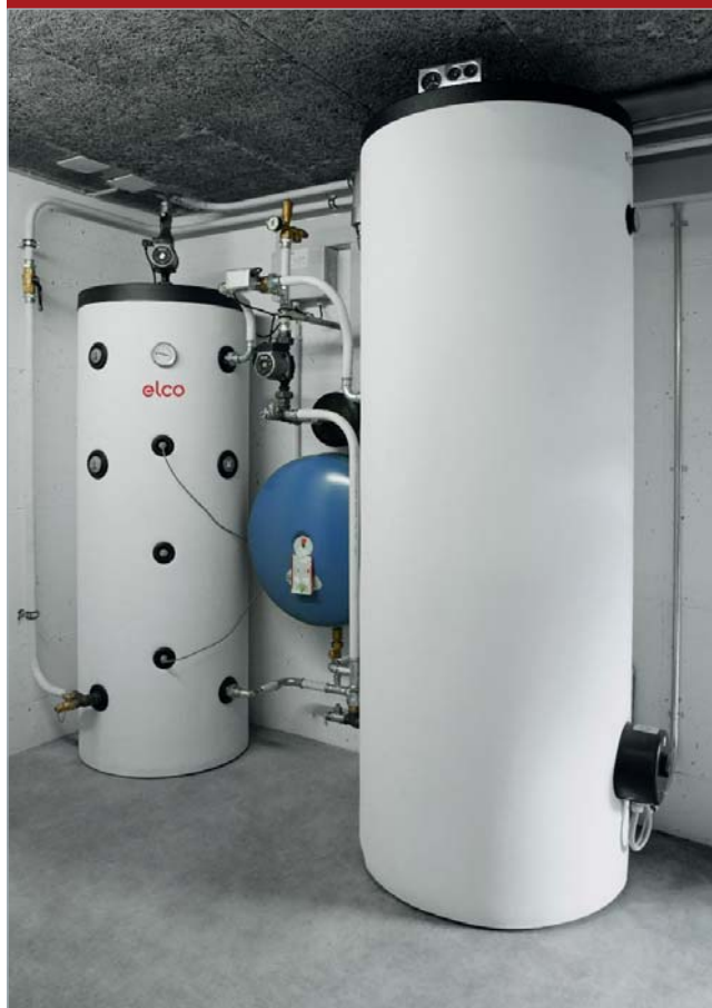
Blick in die Garage
