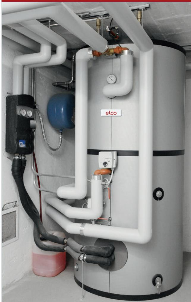
Die Rohrleitungen des neuen Kombispeichers sind gut gedämmt und tragen zum Energiesparen bei.
