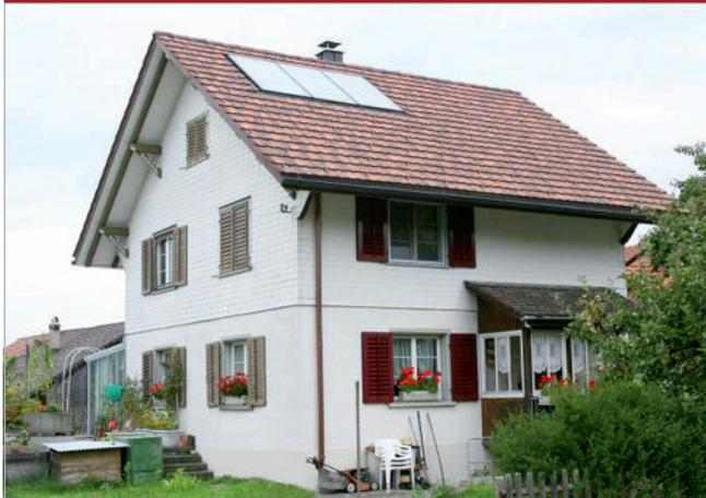
Die Solaranlage dient zur Warmwasserbereitung und Unterstützung der Wärmepumpe.
