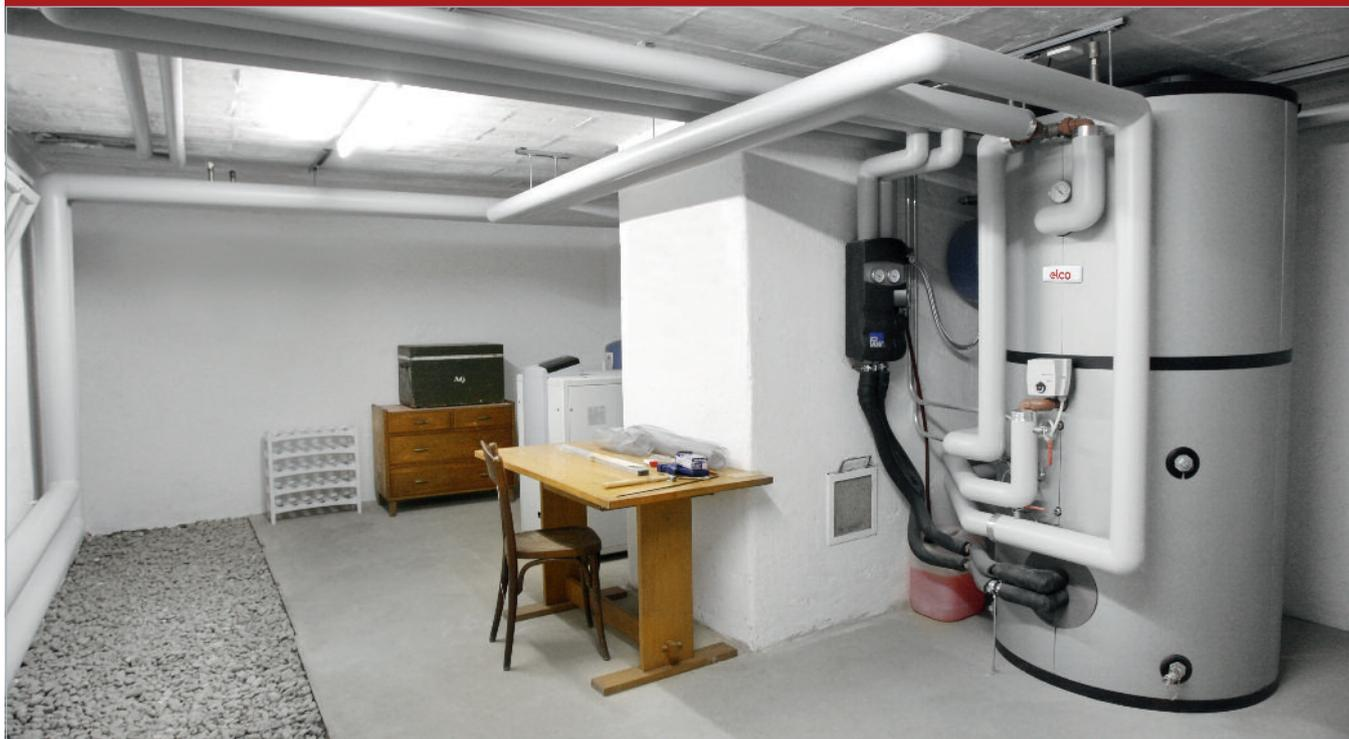
Die neue Wärmepumpe AQUATOP TC08 und der Kombispeicher von ELCO nach perfektem Um- und Einbau.
