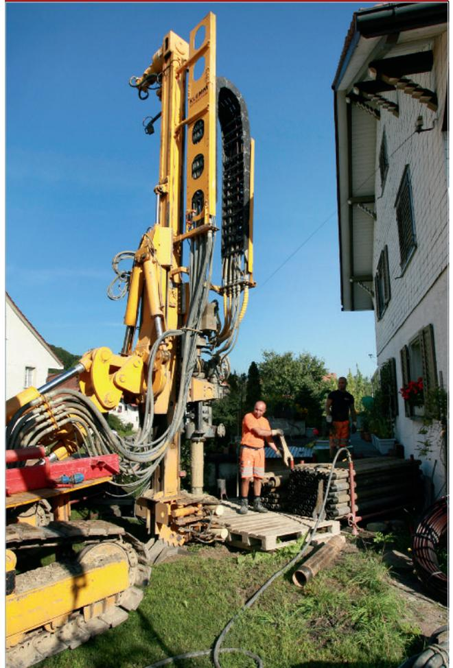
Die Bohrung erfolgt auf eine Tiefe von 150 Metern. Pro Meter werden rund 10 Liter Heizöl eingespart.
