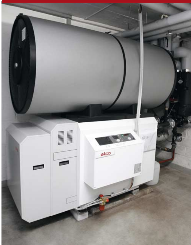
Die neue Öl-Komfortwärmezentrale LNO 80
